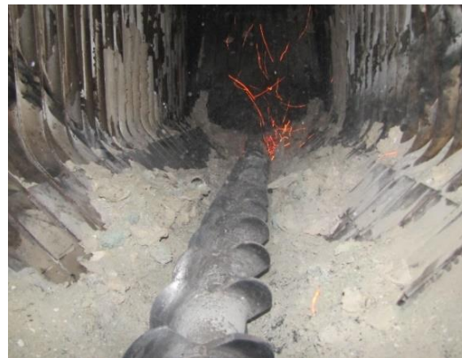
Рисунок 11 – Шнек для удаления золы и шлака из ВТ
