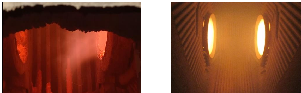
Рисунок 7 – Вид пламени из ГОО: слева – котел с ВТ и двухступенчатым сжиганием; справа – с одноступенчатым по схеме «Торнадо»
