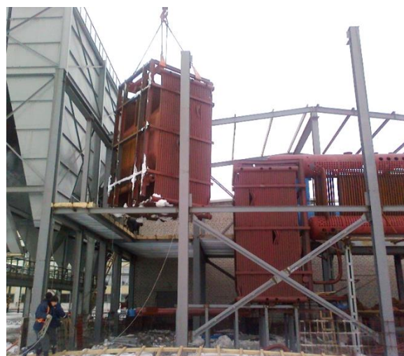
Рисунок 14 – Монтаж блоков ВТ на котле КЕ-25-24 РТО
